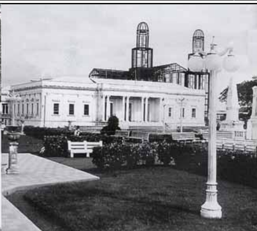
Catedral en construcción, Club Social Managua y el Parque Darío (1934)
